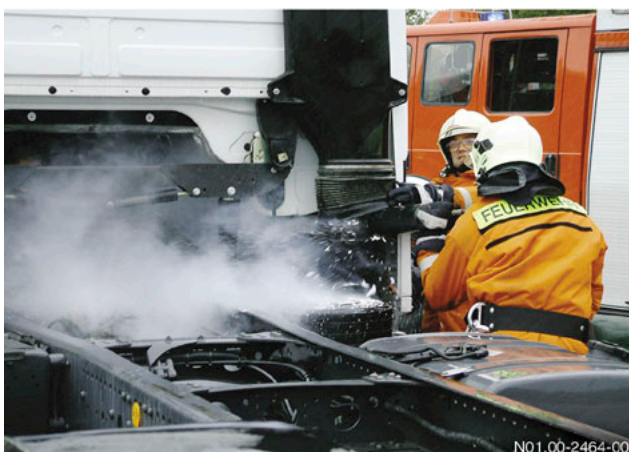
Einblasen von CO 2 in die Luftansaugung
